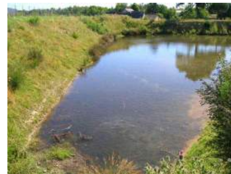
Le bassin de rétention (zone nord-ouest)
