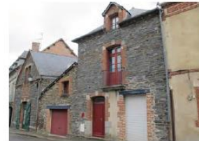
3. EDIFICE SIGNIFICATIF ET/OU CONSTITUTIF DE L'ENSEMBLE URBAIN
