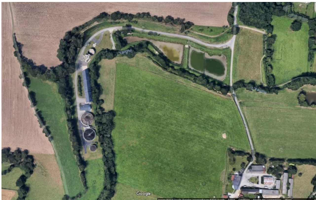
Vue aérienne de la station d'épuration de Montgazon (source : google maps)
