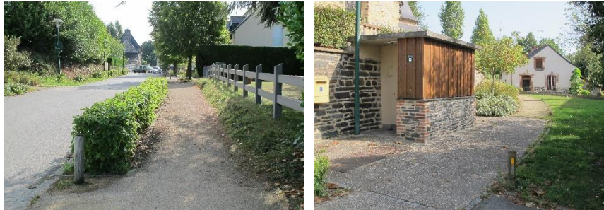
Traitement des déplacements doux, accompagnement végétal
